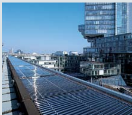
Рис. 11. Установка Vitosol 200-T на плоских крышах
