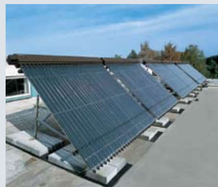
Рис. 12. Установка Vitosol 300-T в произвольном месте
